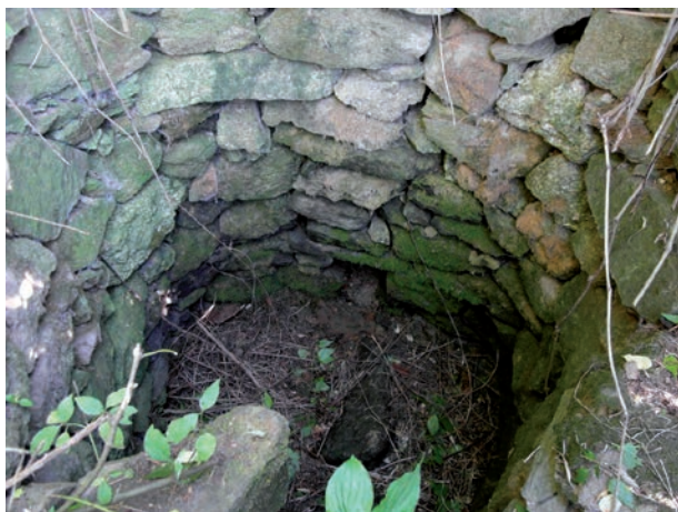
Obr.1 servisná šachta - kamenná skruž
